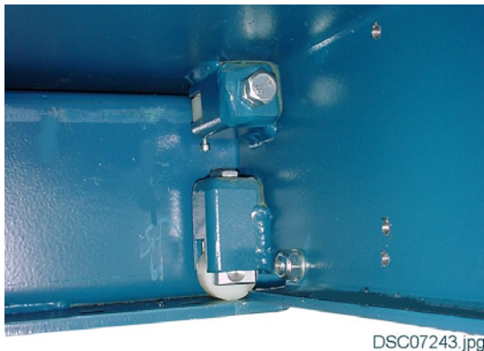
Bild 3: Rollen an der Auffahrschiene um die Verstellbarkeit zu erleichtern.
